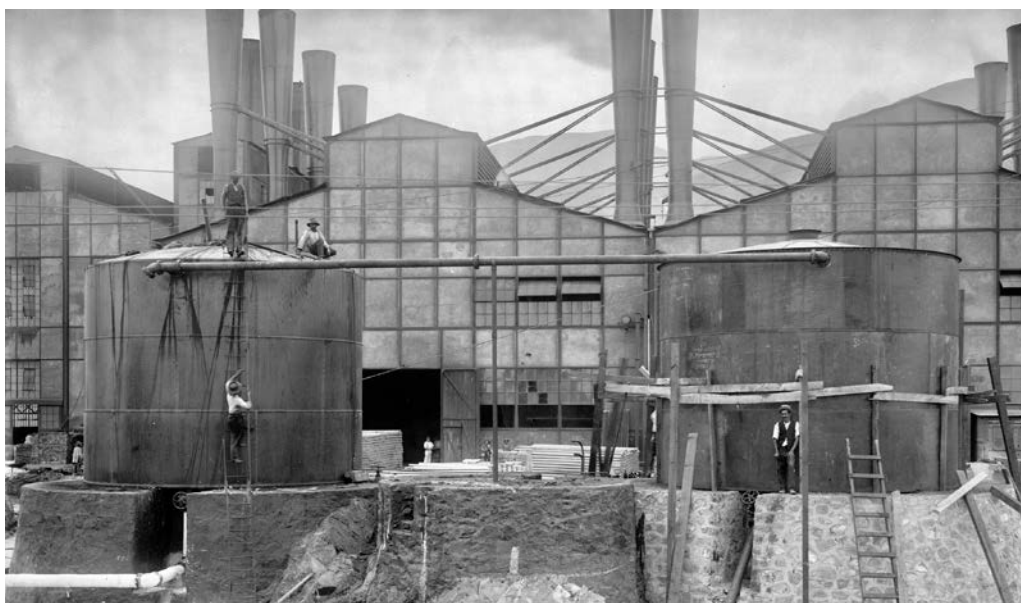
Figura 2. Labores cotidianas de los obreros en la Planta termoeléctrica.
