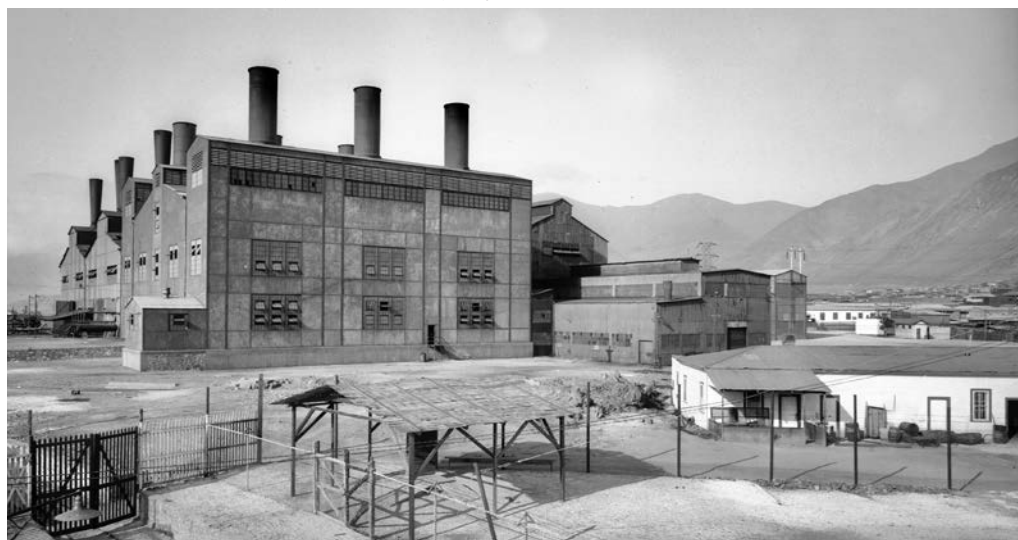
Figura 1. Panorámica de la Planta termoelectrica implementada en 1915 por la familia Guggenheim, a través de The Chile Exploration Company , para electrificar el mineral de Chuquicamata.
