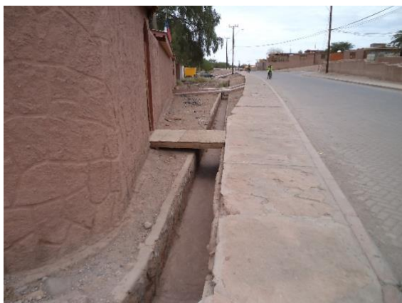
Figura 6. Canal de regadío de piedra con puente
