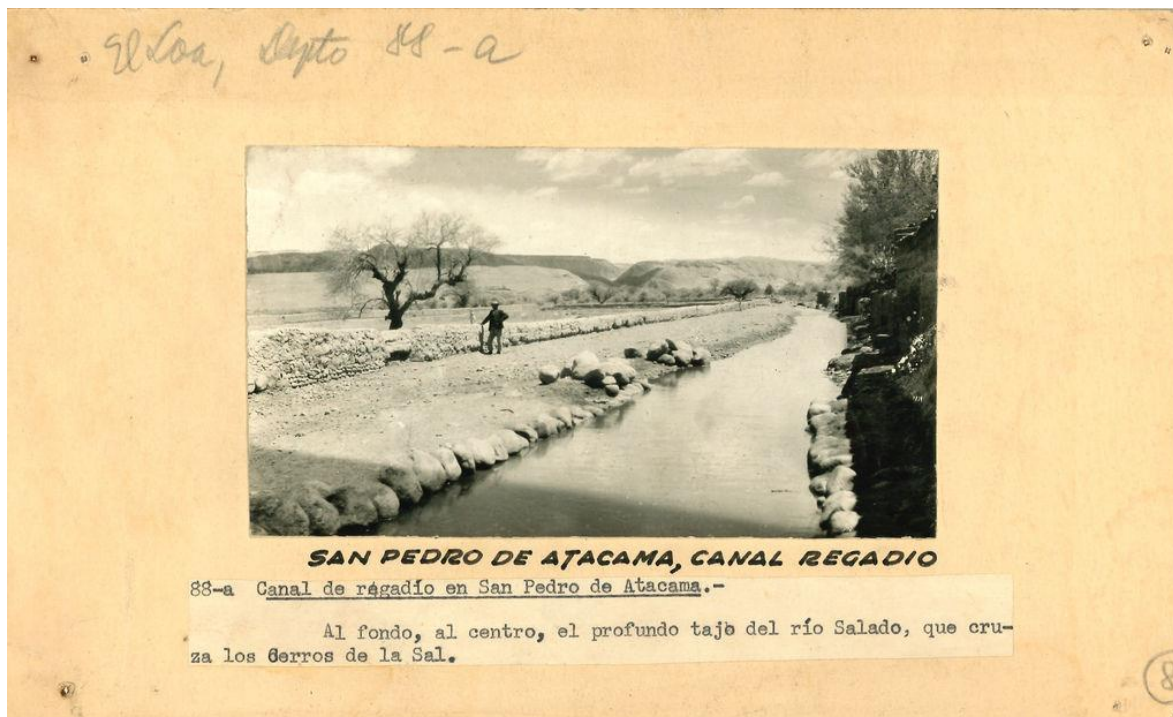
Figura 4. Canal de riego de tierra, SPA, Sin fecha
