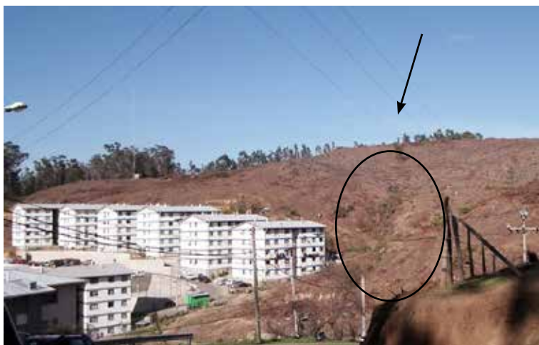
Figura 5. Conjunto habitacional Villa Las Cumbres ubicado en zona de riesgo, indicado con círculo.
