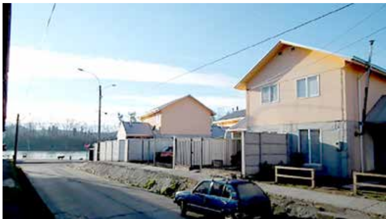
Figura 6. Conjunto habitacional ubicado en la costanera, zona de mayor peligro de inundación.
