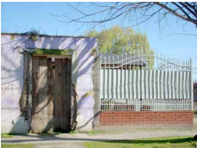
Figura 12. Antigua fachada de adobe adosaba a nueva reja. Fuente: Archivo personal, 2012.
