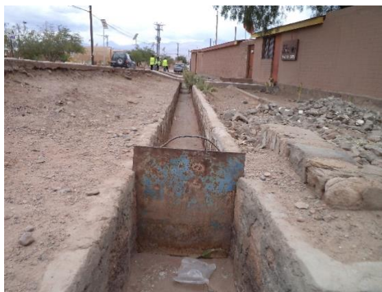
Figura 7. Canal de regadío de piedra con compuerta
