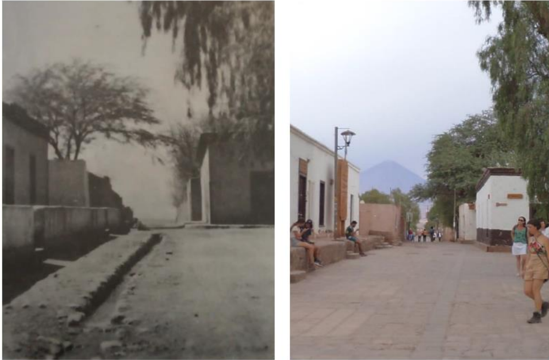
Figura 5. Comparación 1960-2018 Calle Gustavo Le Paige con y sin acequia Antigua calle Antofagasta (ahora Calle Gustavo Le Paige) con vista hacia el oriente con vieja acequia, 1960 Calle Gustavo Le Paige con vista hacia el oriente sin acequia, 2018.
