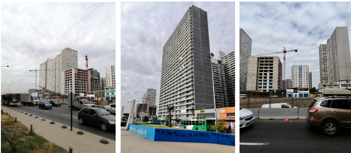
Figuras 3, 4 y 5: La irrupción de las torres en el tejido urbano de Estación Central. Fuente: Luis Campos Medina.
