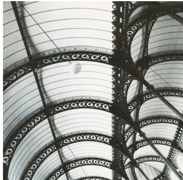
Fig 2. Biblioteca de Saint Geneviève, París. Fuente: Loyer, F. (1983). Architecture of the industrial age. Ginebra: Skira.
