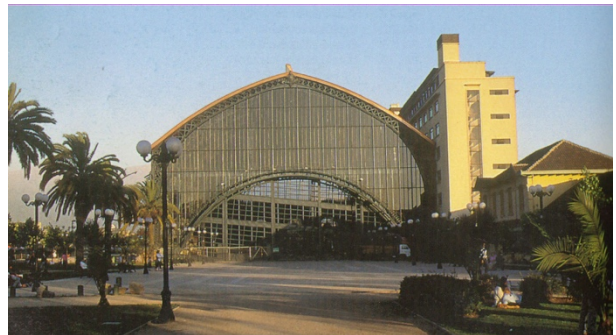
Fig 22. Estación Mapocho. Fachada poniente. Fuente: Basáez Yau, P., & Amadori Gunderlach, A. M. (1995). Estación Central / Estación Mapocho: construcciones ferroviarias en Santiago . Santiago de Chile: Universidad de Chile, Facultad de Arquitectura y Urbanismo.
